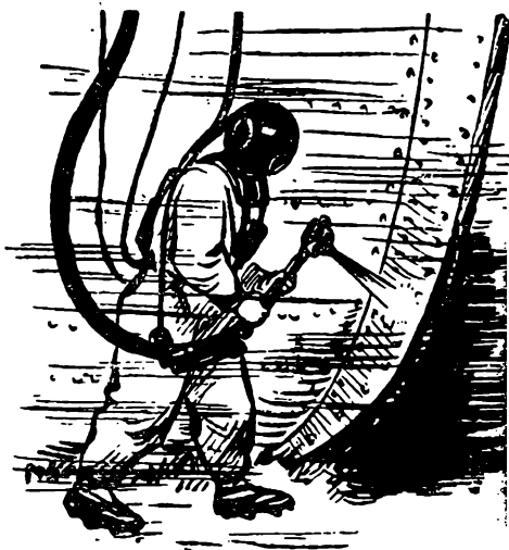
Рис. 36. Работа огнем под водою.
