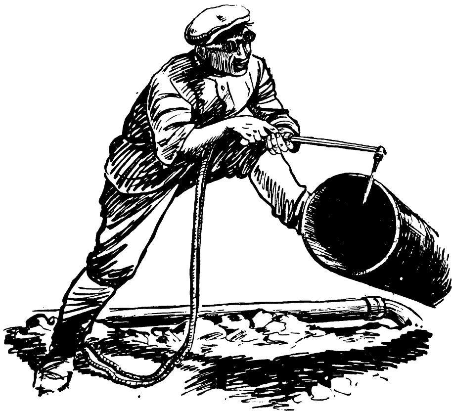
Рис. 17. Обрезка концов труб нефтепровода перед сваркой.
