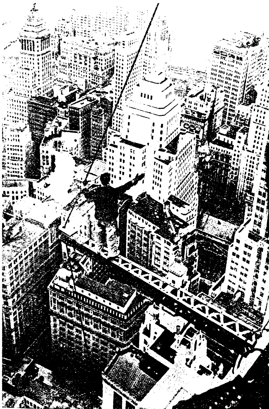
Рис. 43. На постройке небоскреба. Рабочий дает указания крановщику.
